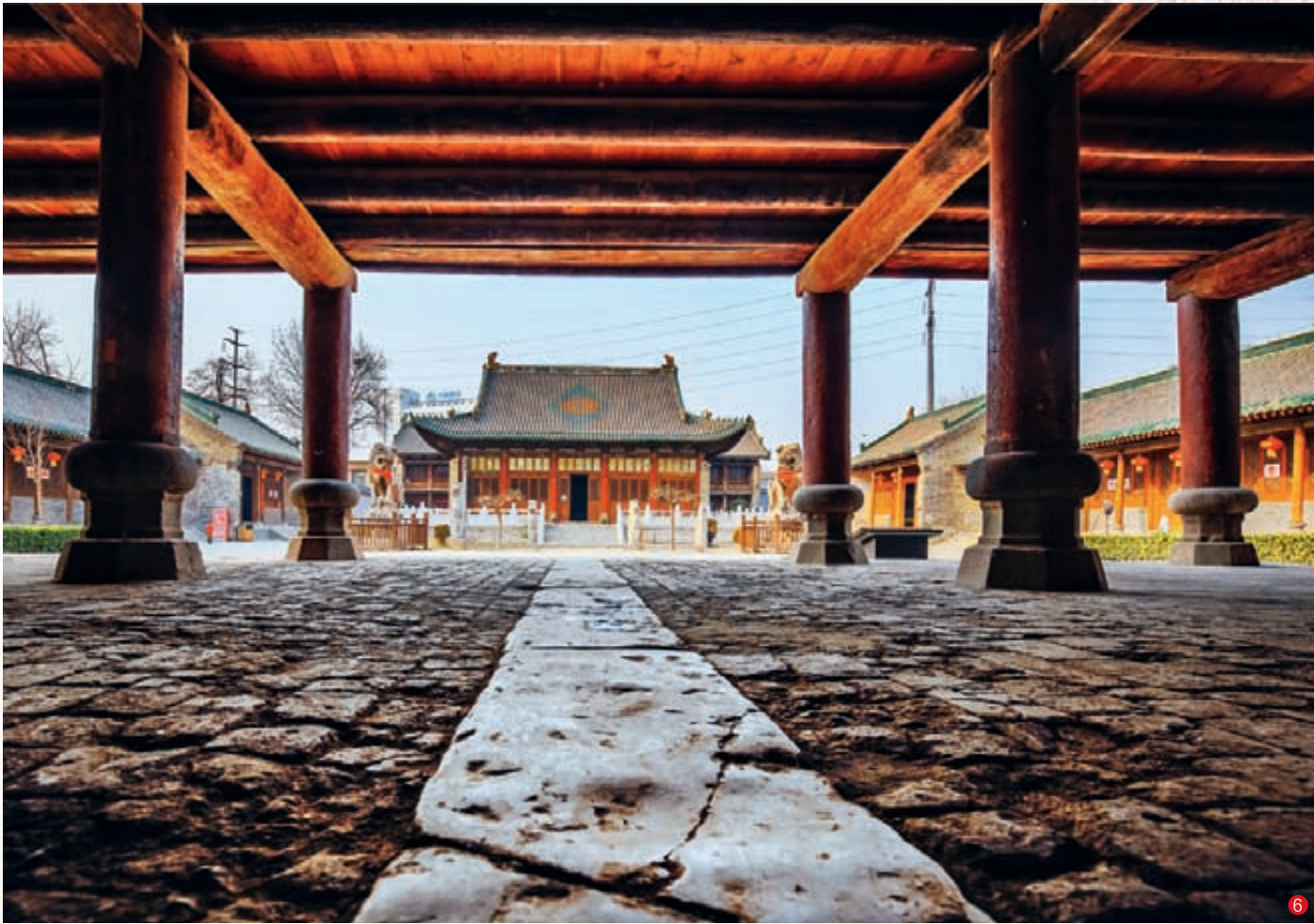
1-5 隋唐大运河博物馆内建筑。 6 斑驳的地面。
